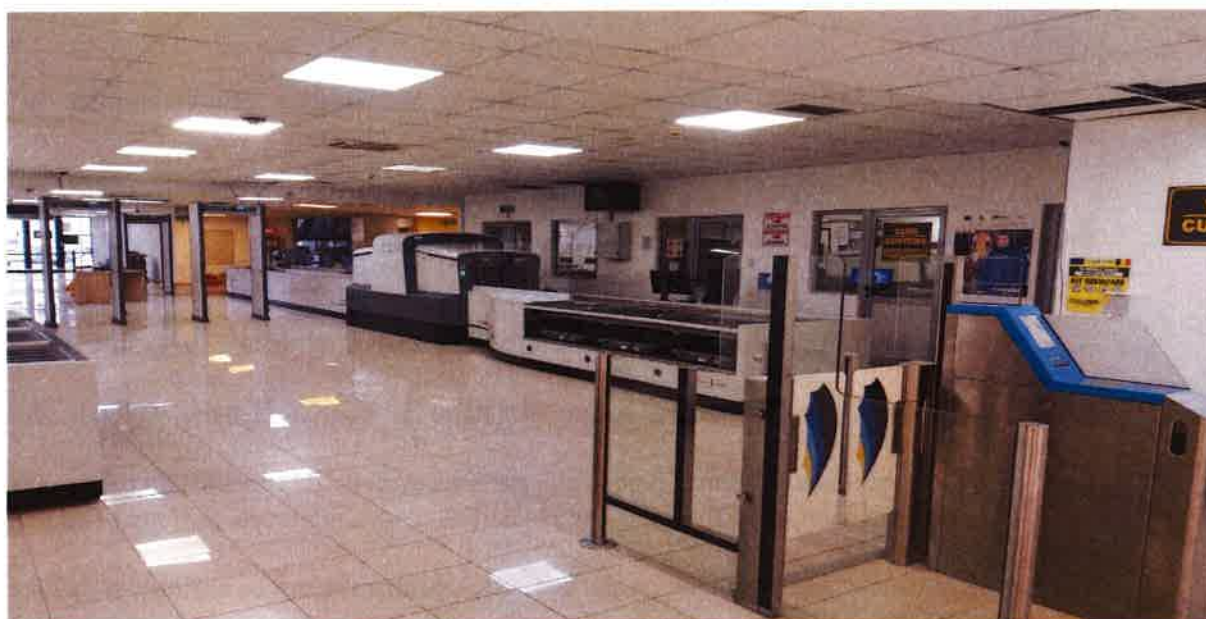
Figura nr.3 Filtru de control al pasagerilor echipat cu echipament de scanare și sistem ATRS Key-line, cu porți detectoare de metale MD 2000
